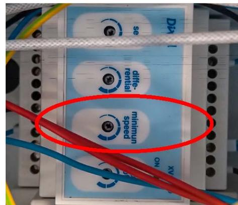
b) Einstellung der Leistung des Ventilators: AC-Variante
