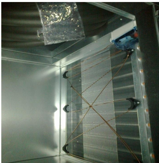
Obrázek 24 – Montáž kapiláry protimrazového termostatu TS1-C0P
