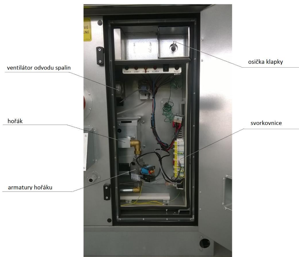
Obrázek 25 – Vnitřní instalace plynového hořáku Monzun
