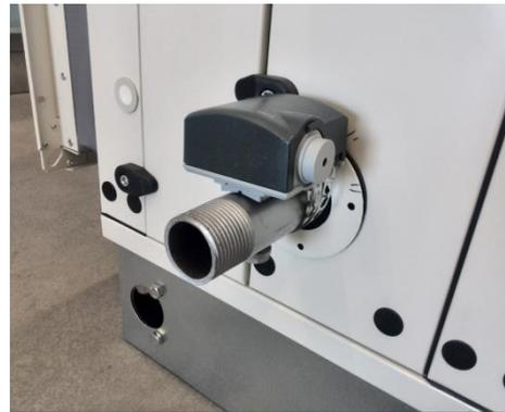
Abbildung 9 - Kontakttemperatursensor QAD36/101 und seine Montage am Ausgang des
