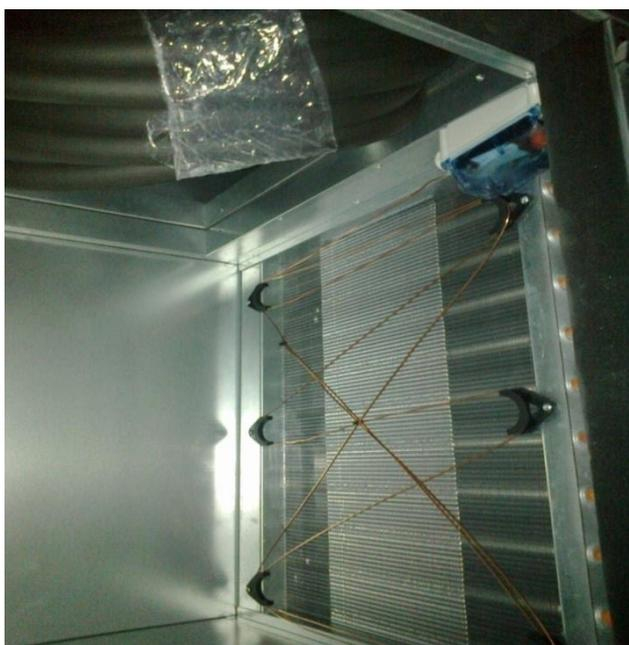
Abbildung 24 - Montage der Kapillare des Frostschutzthermostats
