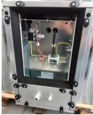
Abbildung 28 - Interne Installation der elektrischen Heizung
