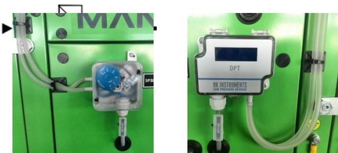
Abbildung 12 - Anschluss der Druckreglereingänge und Montage an dem Mantel der HLKK-
