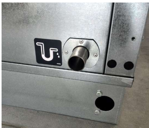
Vývod kondenzátu deskové rekuperace
