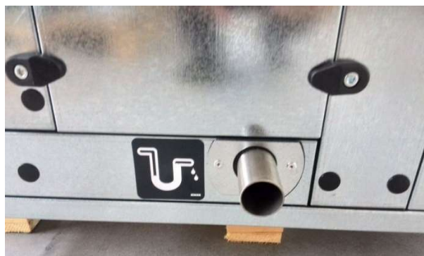
Vývod kondenzátu chladiče (vodní/výparník)
