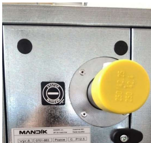
Označení vstupu do výměníku
